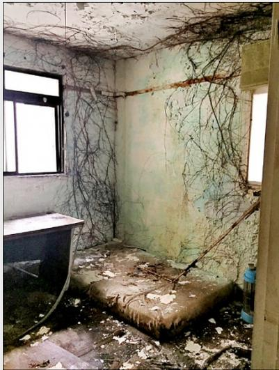
建物內部已被樹根盤據，結構破壞。（新北市都市更新處提供）
