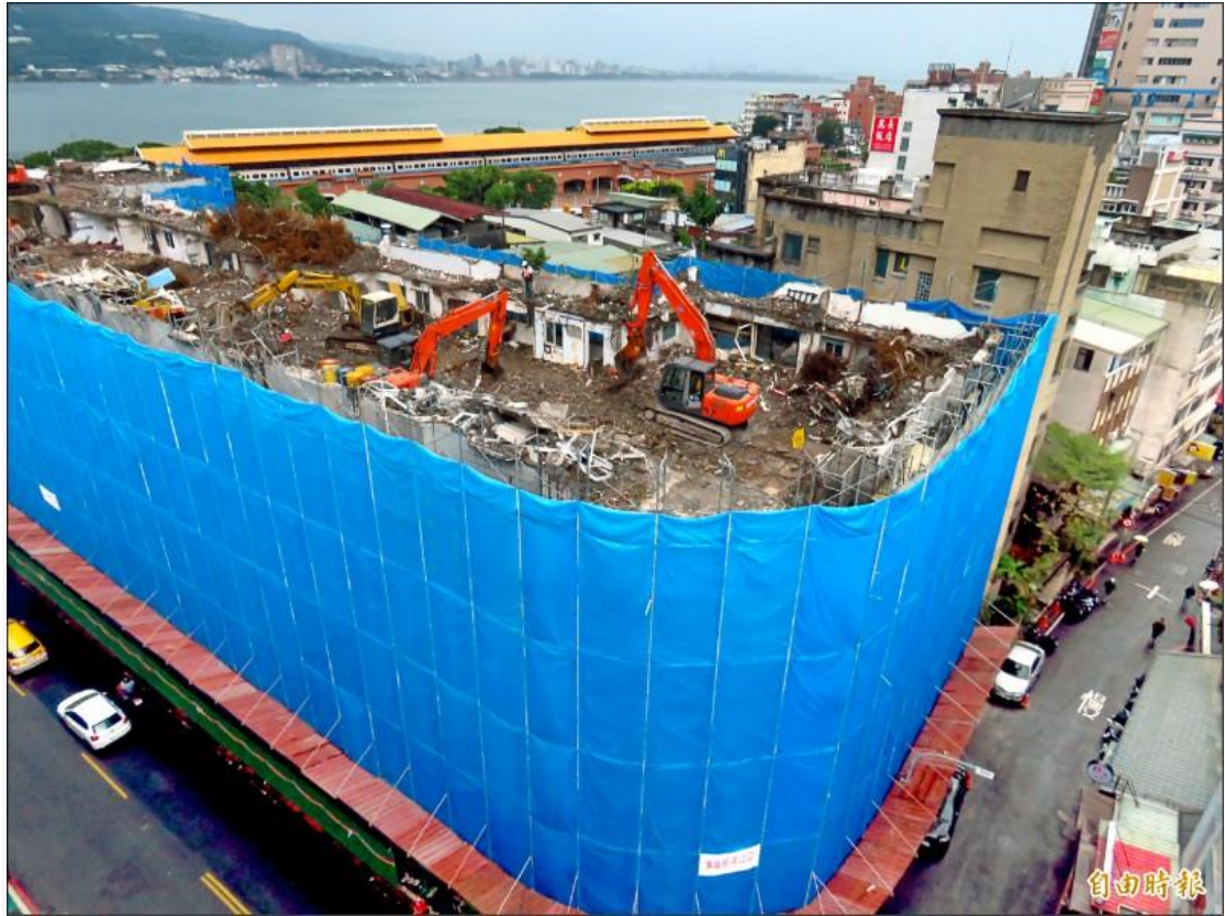
淡水東來大廈在二〇一二年鑑定為海砂屋，預計明年二月前完成拆除作業。 (記者陳心瑜攝)
